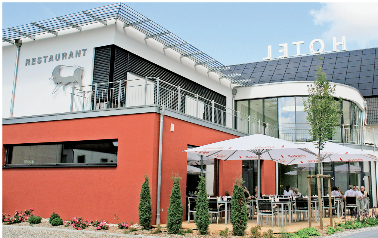
Herausgeputzt: Die Investition in den Gasthof Ochsen im Helfensteiner Land macht sich bezahlt
